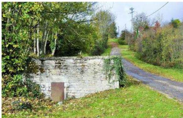
Le réservoir d'eau de Blaisy-Bas étant difficile d'accès, l'eau sera acheminée depuis le camion-citerne, posté au bas de la rue, jusqu'au réservoir grâce à un système de pompage. Photo Nicolas BOFFO
