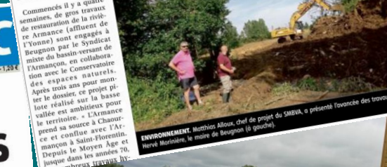
ENVIRONNEMENT. Mathias Alloux, chef de projet du SMBVA, a présenté l'avancée des travaux avec Hervé Morin, le maire de Beugnon (à gauche).
