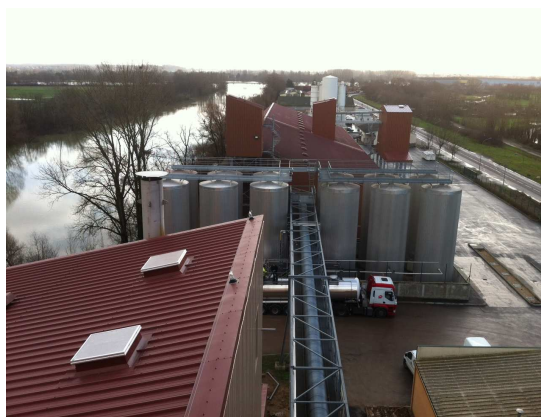
L'entreprise EXTRUSEL - Crédit photo : Extrusel / Coopérative Bourgogne du Sud
