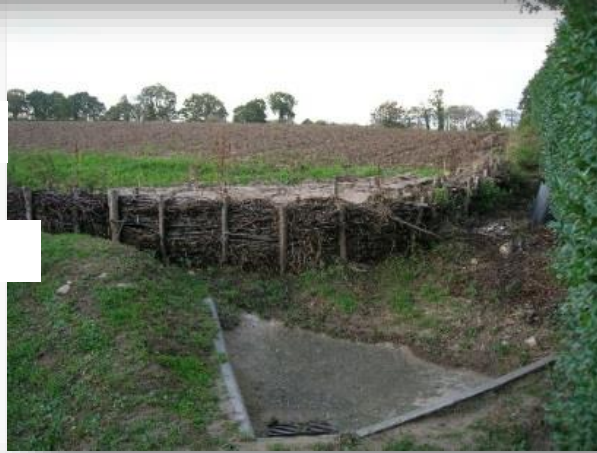
Frein hydraulique sur le parcours : Mise en place de fascines
