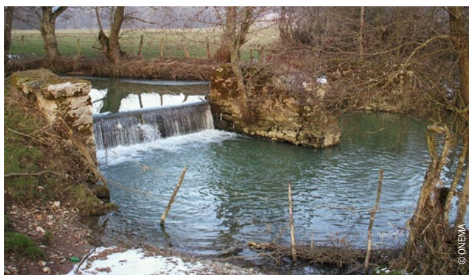
Barrage sur l'Arroux : un obstacle au déplacement des espèces aquatiques.
