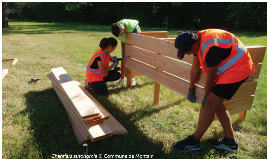
Chantiers autonomie © Commune de Montain
